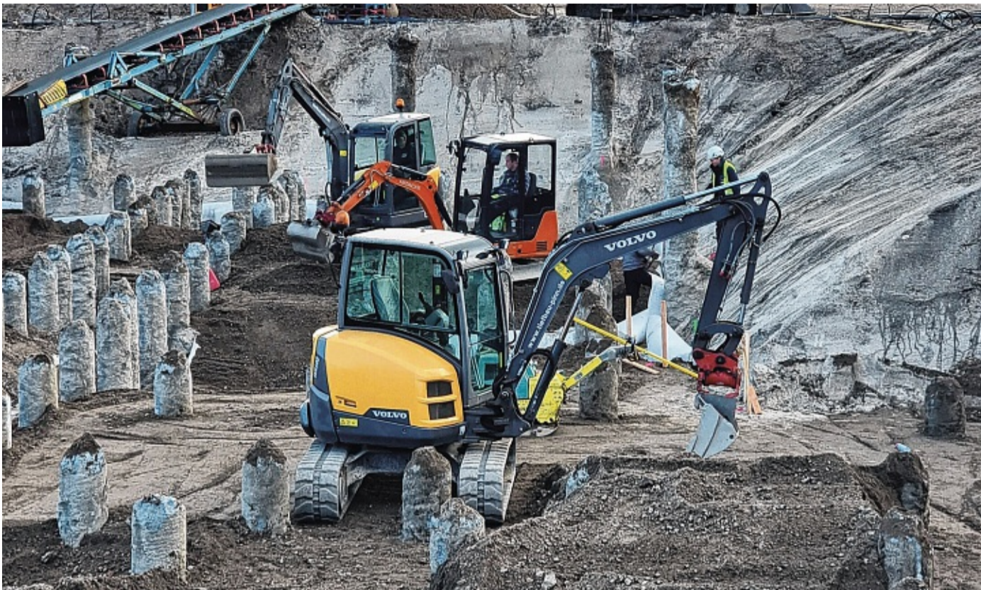
Das leistungsstarke Equipment des Erd- und Tiefbauunternehmens sorgt für Effektivität. Auch auf sogenannten „Extrembaustellen“.
