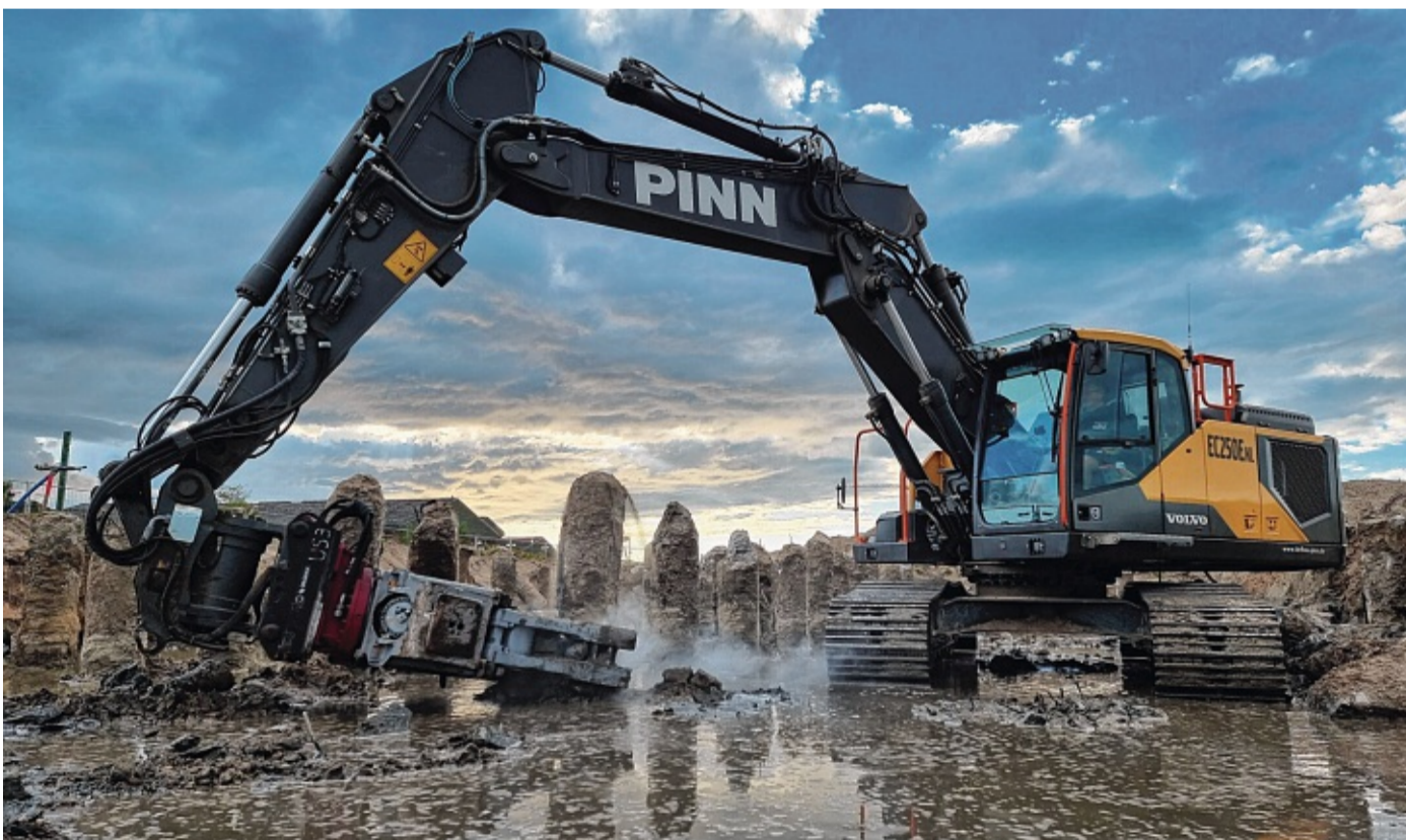
Bei Abbrucharbeiten leisten unter anderem Betonscheren einen entscheidenden Beitrag. Foto: Erd- und Tiefbauunternehmen Holger Pinn
