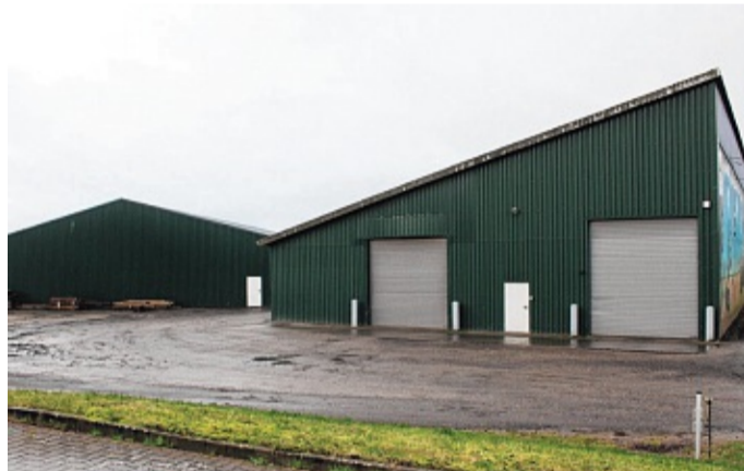
Auf einem Gewerbegrundstück in der Gemeinde Sörup errichtete das Unternehmerehepaar zwei Hallen für die Unterbringung der gesamten Fahrzeugflotte.
